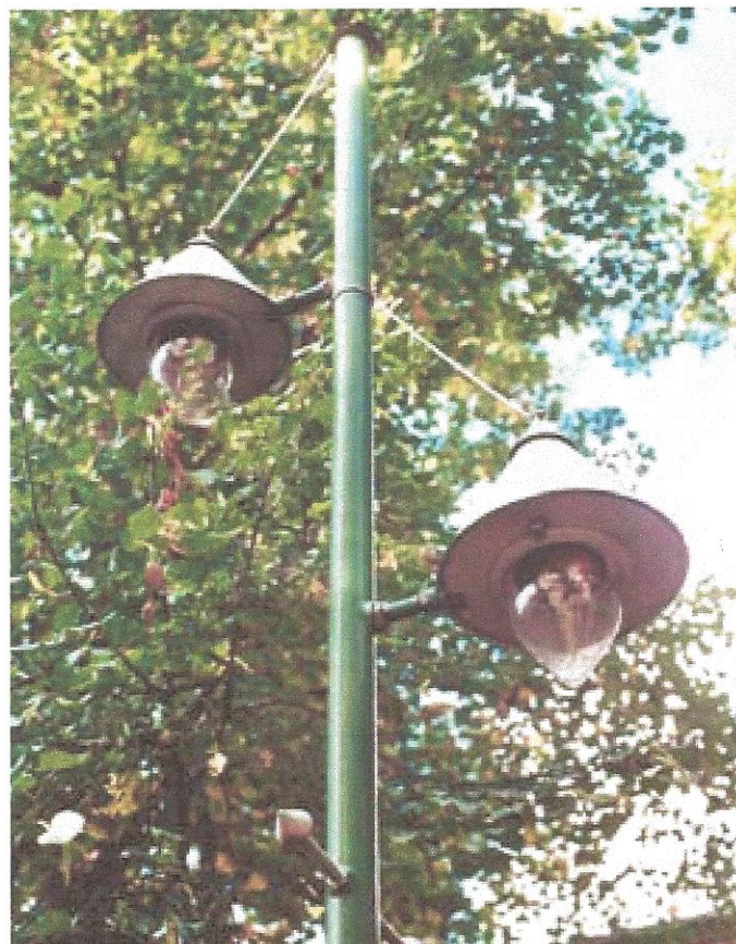
B-Schöneberg/GASAG-Gelände, Moderner Entwurf einer doppelten Ansatz-Gasleuchte (kam nie zum Einsatz), konstruiert von der GASAG Bild: Bettina Grimm
