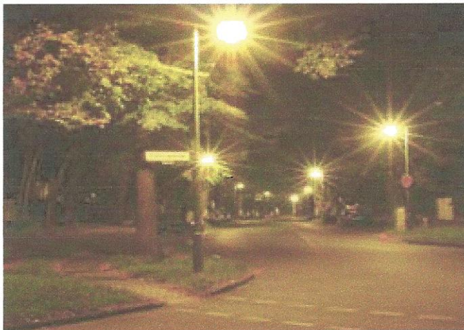
B-Zehlendorf, Abendliche Impressionen: Gas-Hängeleuchte in Betrieb
